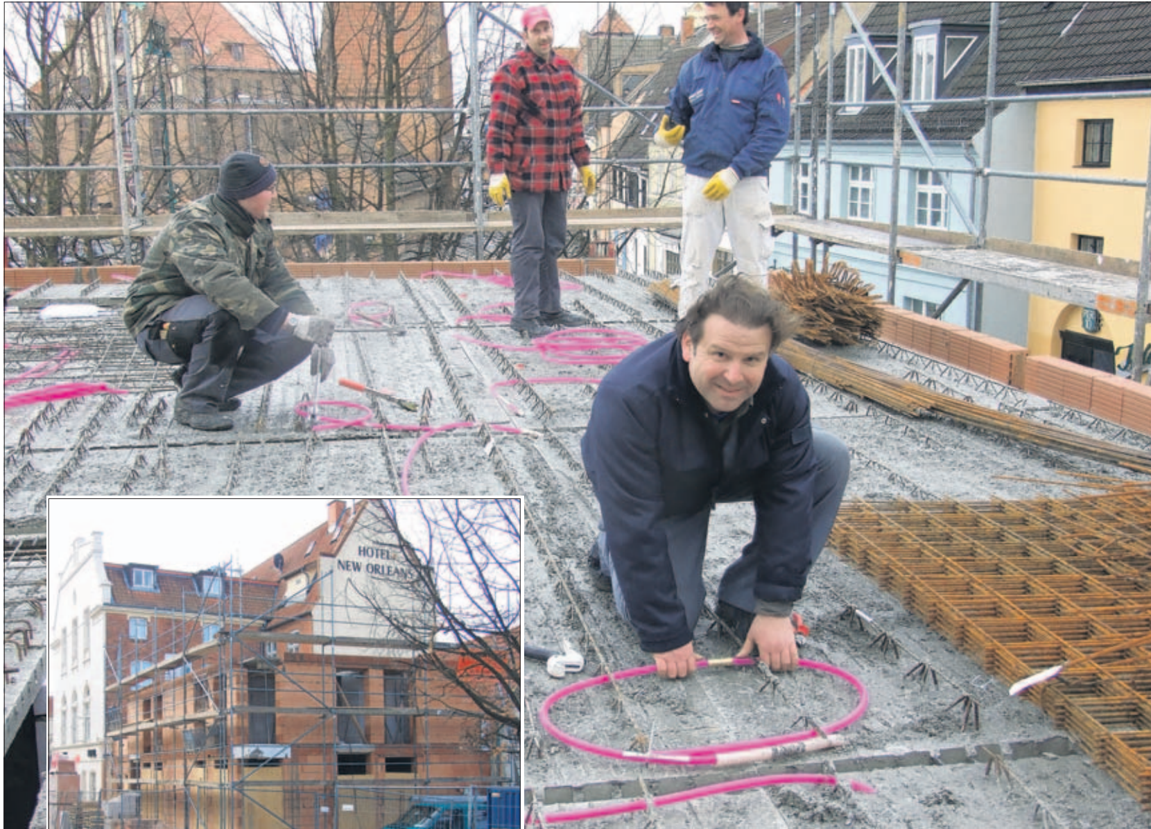
Uwe Wyrich (im großen Bild vorn) ist der Erfinder des neuen Patents zur Beheizung von Gebäuden mit Erdwärme von der Decke her. Er überwacht die Arbeiten beim Erweiterungsbau des Hotels „New Orleans“ am Lohberg (kleines Foto). Fotos: T. V.
